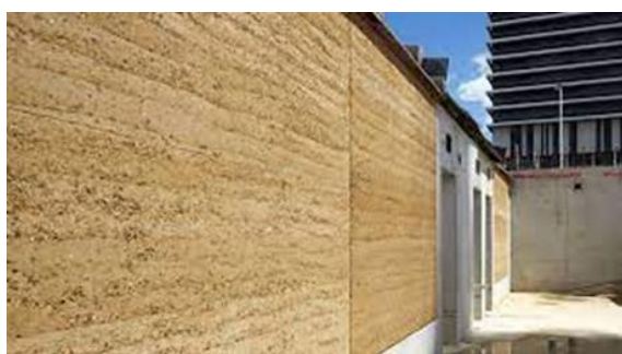
Figure 5. Façades en briques de terre compressée
