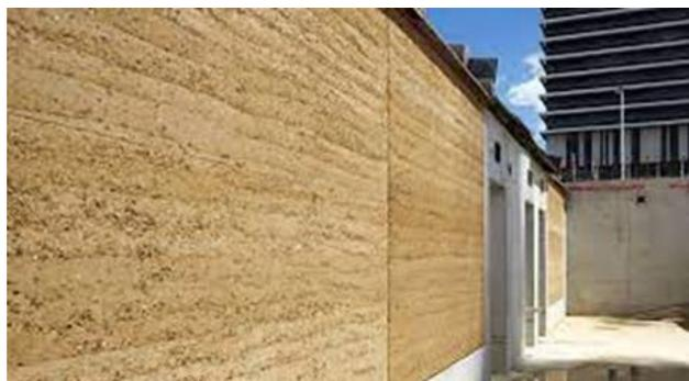
Figure 5. Façade en briques de terre compressé cuite
