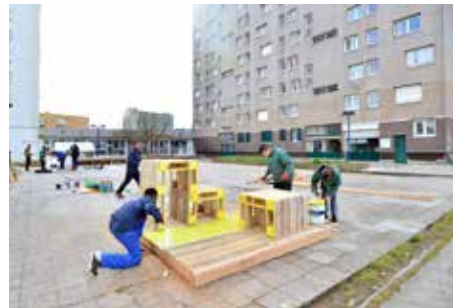
DALLE MAURICE THOREZ (RE-)CONSTRUIRE UN ESPACE CITOYEN CO-CONCEPTION CO-CONSTRUCTION DES AMÉNAGEMENTS IMPLICATIONS DES ASSOCIATIONS
